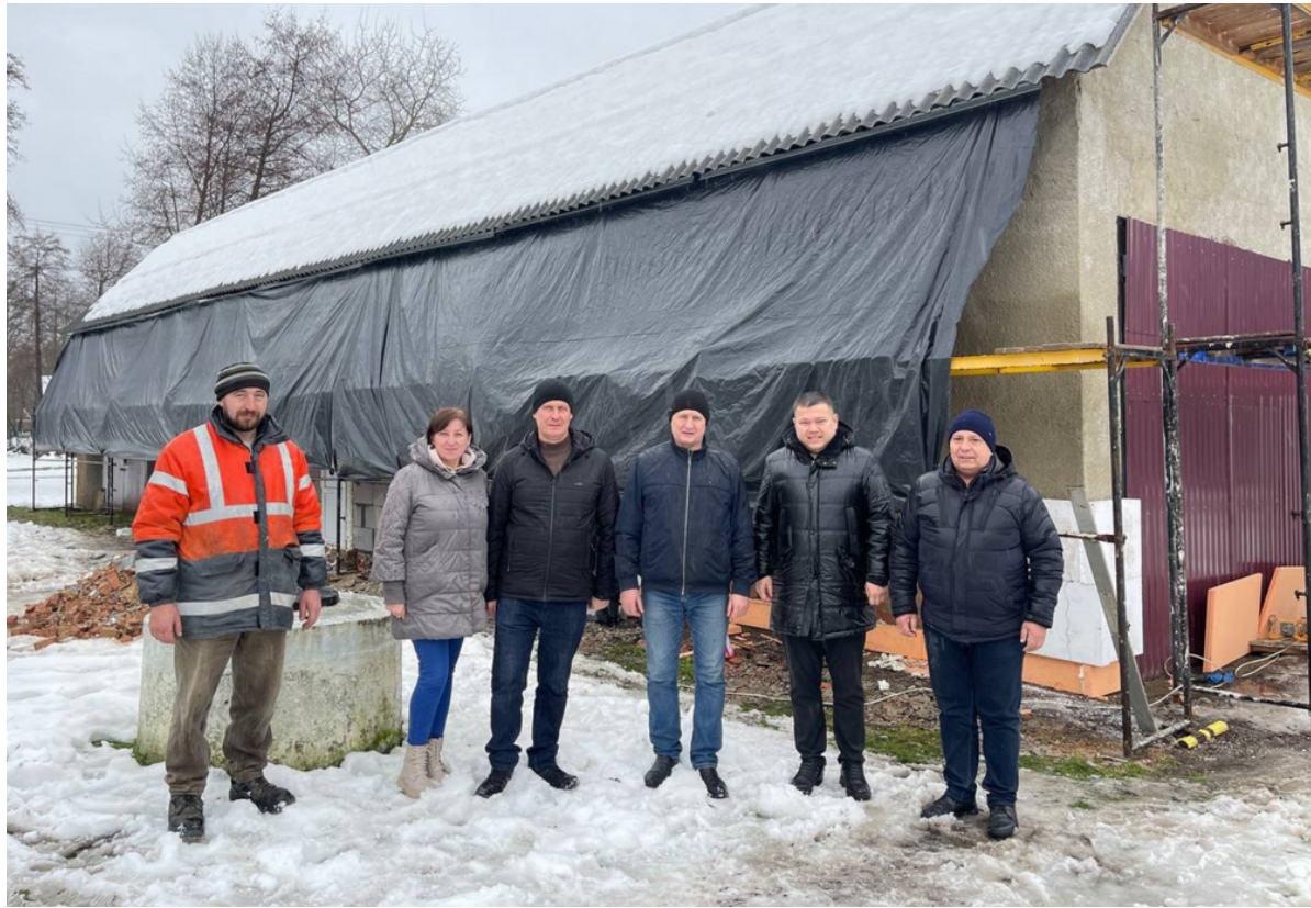
Місцеві жителі активно долучалися до ремонтних робіт та облаштування депо для вогнеборців
