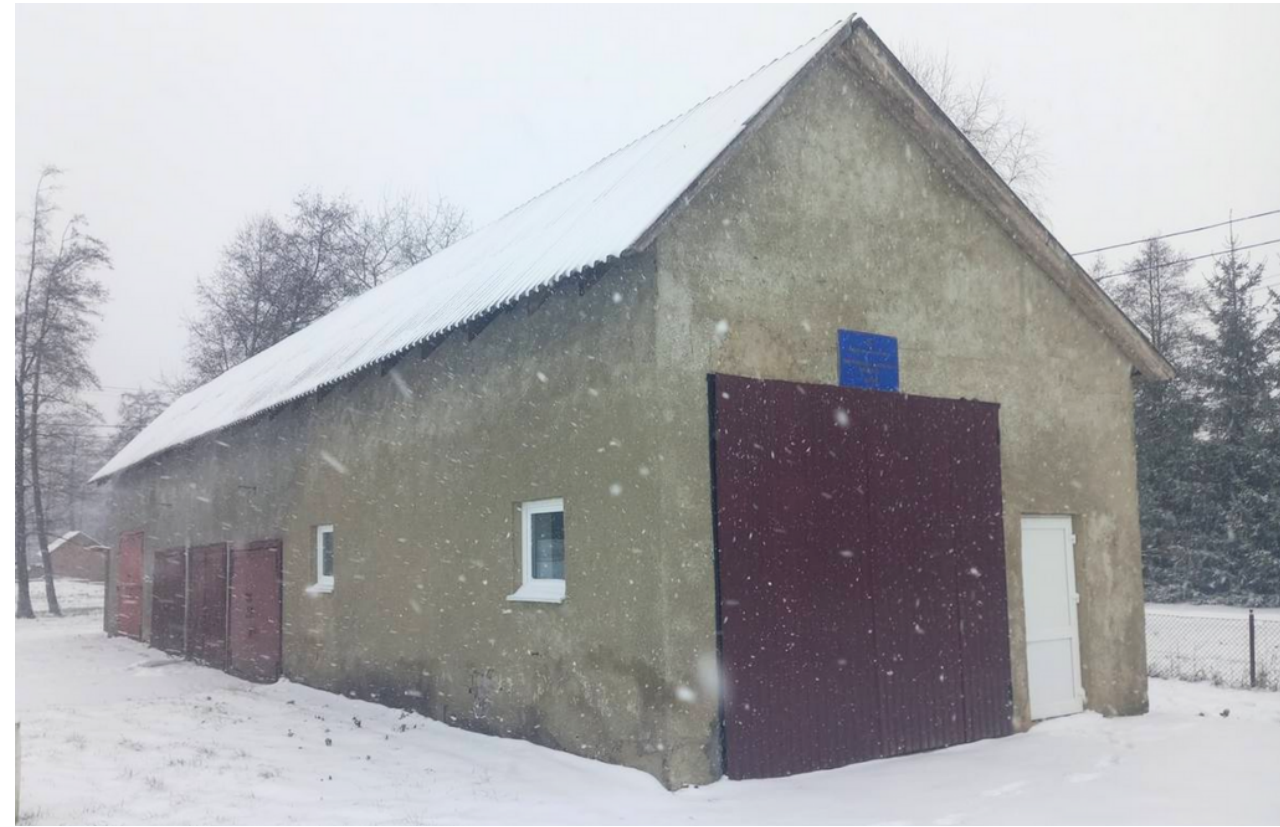
Відремонтований фасад пожежного депо
